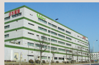
日本電産(大連)有限公司 NIDEC (DALIAN) LIMITED
